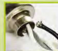
Ruptura de fio por torção
