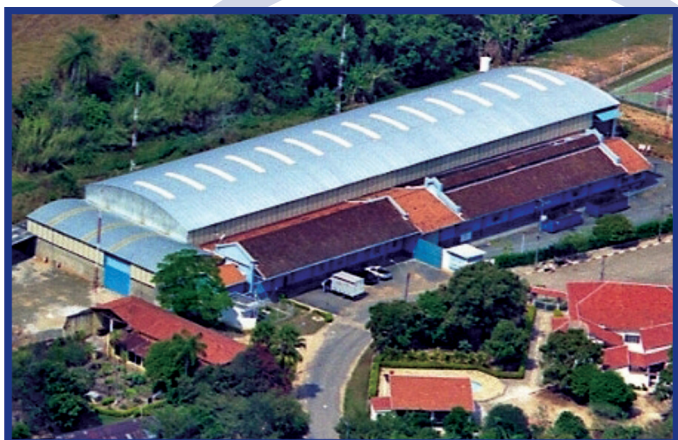
Unidade Fabril - Itapira-SP Metalúrgica Solano Ltda. Área construída 6.500 Mt's Área total 8.500 Mt's
